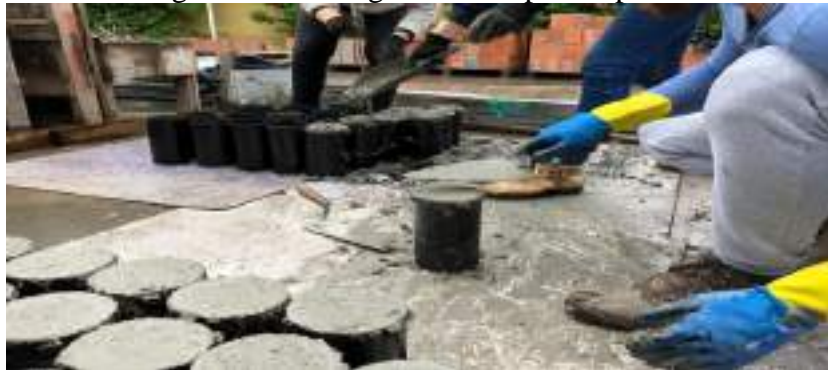
Figura 1 – Moldagem dos corpos de prova.
